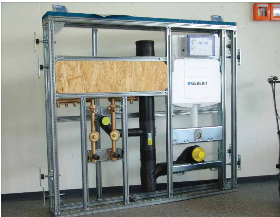
Vorfabrikation von PE-Abläufen und GIS-Vorwandelementen.
