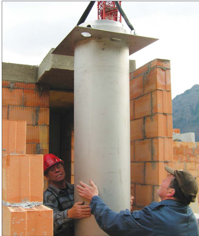
Kaminabgaswärmetauscher beim Einbau. Er gewinnt Energie aus Abgasen eines Cheminée.
