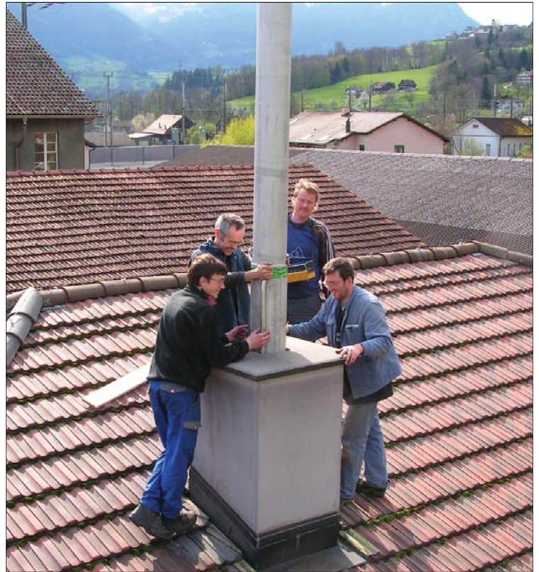
Wärmetauscher für eine Hackschnitzelfeuerung in Steinen.
